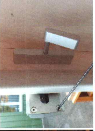
17 - Montez & Bloquez la Manette (Fermé en Bas) puis Enfillez la Tole Inox & monter les 2 Vis FHC-M4
