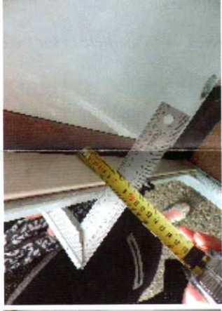
3 - Mesure de la Cote Mini - Ici 62
