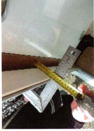
2 - Mesure de la Cote Maxi - Ici 87
