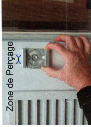
7 - Ici Fixation Directement sur le Panneau
