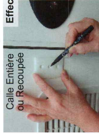
11 - Tracez et Percez 3 Trous Ø 9
