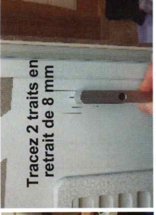
5 - et Déterminez la zone de perçage Mini/Maxi
